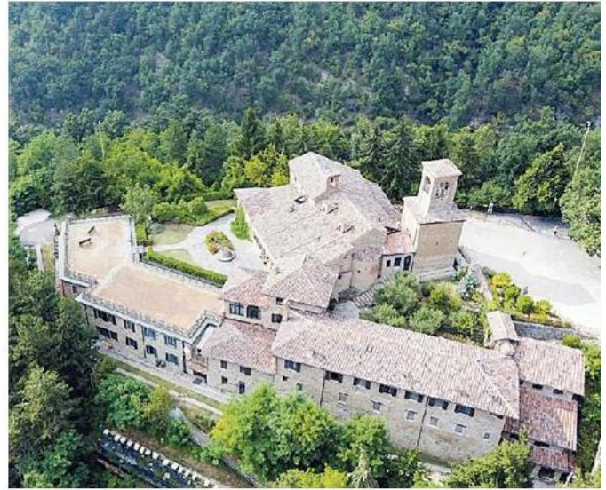
Dettaglio del complesso dell'eremo di Sant'Alberto, con il campanile di Sant'Alberto.
